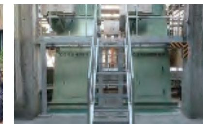
下水道ポンプ場設備新設
