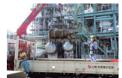
プラント定修
