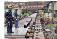
搬送テーブル整備
