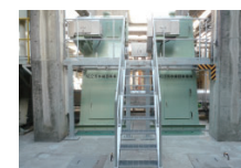
下水ポンプ場設備新設
