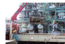
プラント定修
